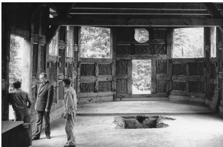
fot. 9. Garbno – wnętrze kościoła w trakcie remontu w 1985 r., skan ze zbiorów WUOZ, Delegatura w Koszalinie
