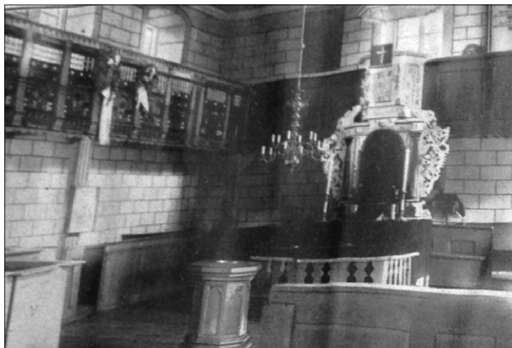
Wnętrze kaplicy ewangelicka we wschodnie oficynie pałacu
