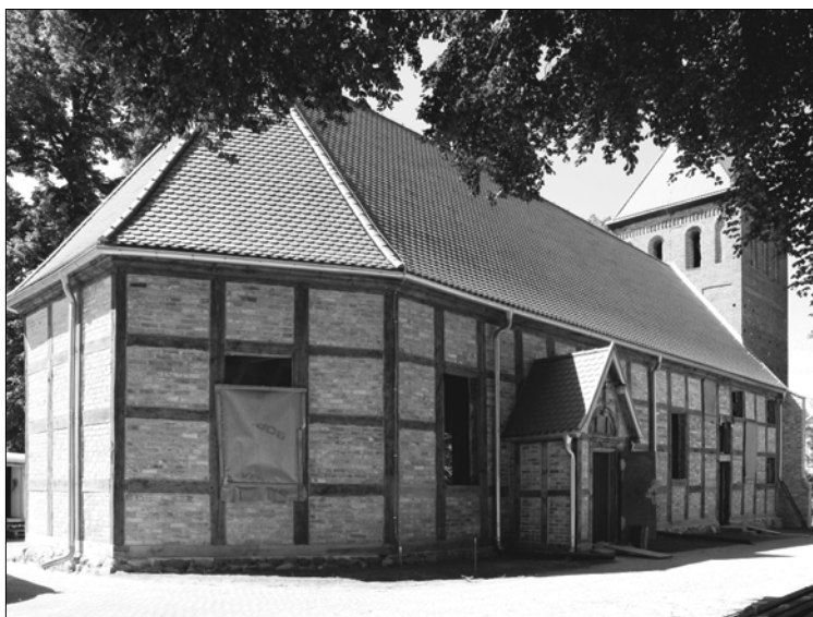
fot. 11. Sianów – kościół, widok od płn.-wschodu (w trakcie remontu), fot. T. Prajzendanc, 2017
