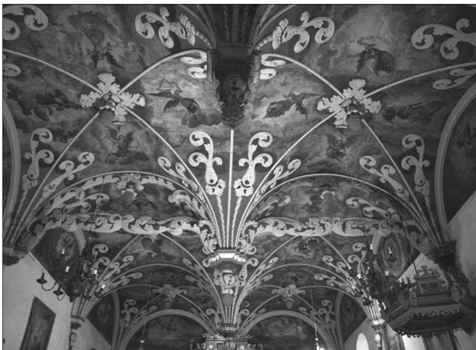
7. Brzesko, pow. pyrzycki, gm. Pyrzyce, kościół par. pw. Narodzenia NMP, drewniane sklepienie pozorne z polichromią, 1697, fot. T. Makulec
