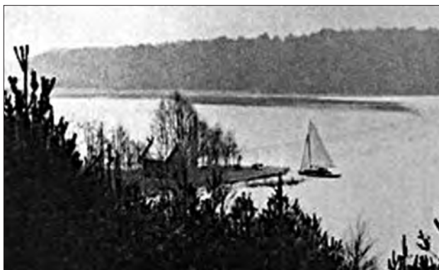
Drewniany dom na Syrenim Cyplu, w którym mieszkał Hans Troschel w latach 1932–1936
