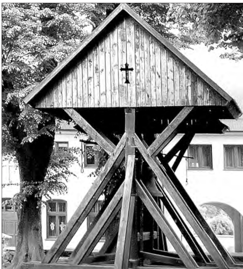
4. Dzwonnica kozłowa z dzwonem odlanym w 1730 roku, stojąca obok kościoła pw. Św. Trójcy (fot. Zb. Januszaniec, 2008 r.)
