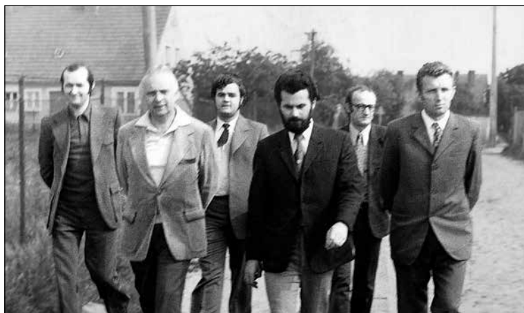
Czaplinek 1974 r. Wizytacja budowy Telkom-Telcza przy ul. Grunwaldzkiej. Od lewej A. Szwaja, min. J. Hryniewicz, R. Polak, R. Żukowski, R. Szczygieł i F. Łodziato.
