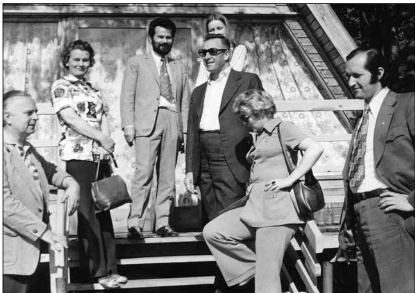
Czaplinek 1975 r. Na budowie Ośrodka Wypoczynkowego na Pięciu Pomostach (obecnie Drawtur). Od lewej min J. Hryniewicz, w środku inż. R. Żukowski.
