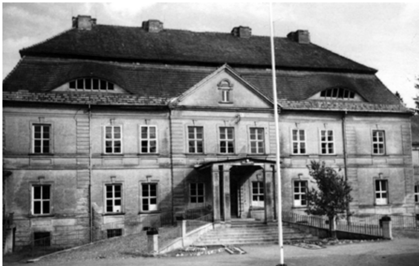
Szkoła po kapitalnym remoncie
