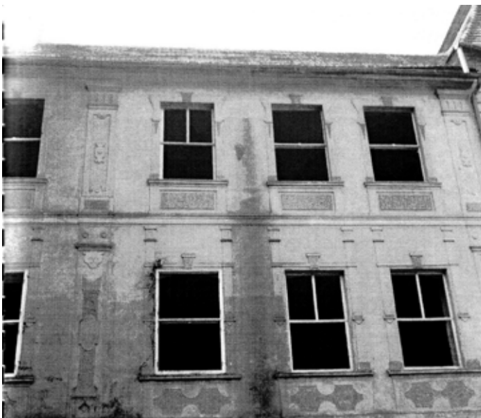
Lata pięćdziesiąte. Stan pałacu przed rozpoczęciem kapitalnego remontu
