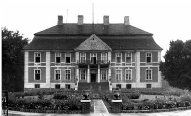
Pałac w Stolcu, fasada. Fot. G. Solecki. Repr z: M. Borkowska, Pałac w Stolcu. Dokumentacja architektoniczno-historyczna . Szczecin 1976 r. (maszynopis w zbiorach NID, oddział terenowy w Szczecinie)
