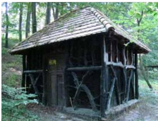
Pompownia wody (altana) w zespole szpitalnym Kańsk, fot. W. Witek, 2012
