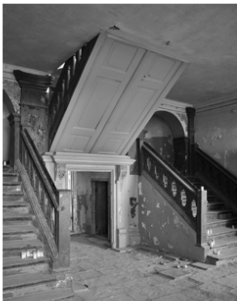
Pałac w Siemczynie. Wnętrze, sień z klatką schodową. Fot. R. Walkiewicz
