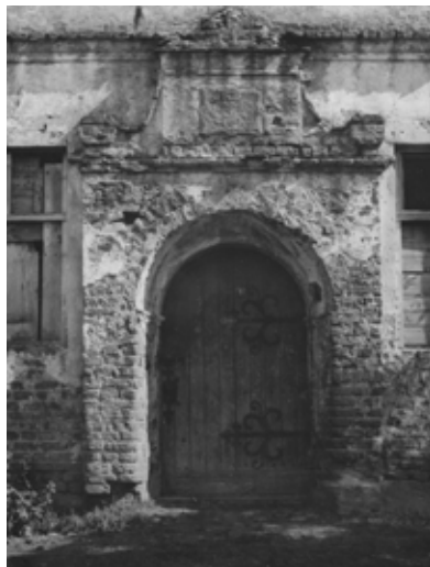
Dwór w Niedyszu. Fragment fasady, portal. Fot I. Springer. Repr z: Z. Radacki. Dwór w Niedyszu. Dokumentacja architektoniczno-historyczna . Szczecin 1965 r. (maszynopis w zbiorach NID, oddział terenowy w Szczecinie)
