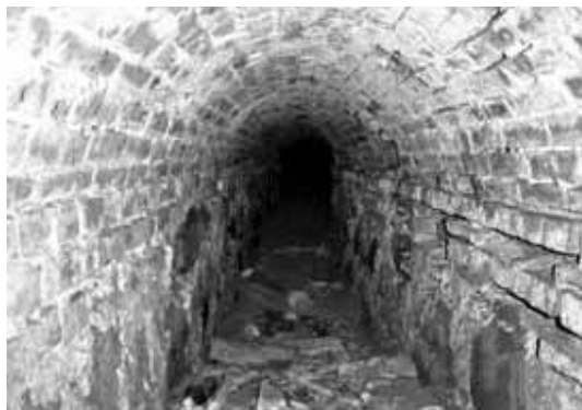
Podziemny tunel – kanał w parku
