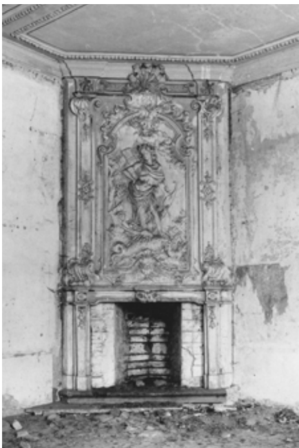
Pałac w Łupawie. Wnętrze, jeden z kominków. Fot. G. Solecki. Repr z K. Kalita-Skwirzyńska, Pałac w Łupawie. Dokumentacja architektoniczno-historyczna . Szczecin 1973 (maszynopis w zbiorach NID, oddział terenowy w Szczecinie)
