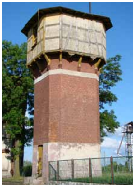
Kolejowa wieża wodna w Drawsku Pomorskim, fot. W. Witek, 2010
