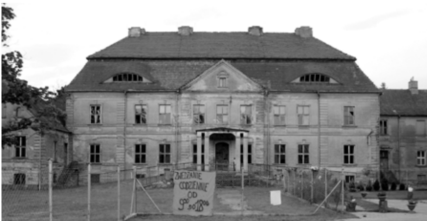
Pałac w Siemczyń, fasada. Fot. R. Walkiewicz
