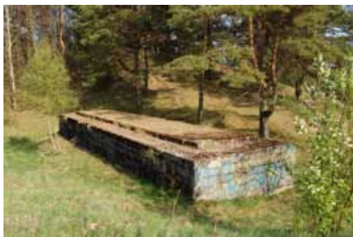
Fundamenty wiaduktu, który miał stać w pobliżu Cieszyna.
