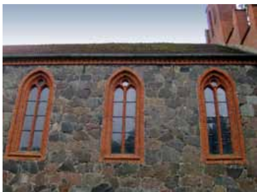
Wygląd północnej ściany kościoła. Ścianę ze starannie obrobionych kamiennych ciosów zdobią neogotyckie okna wykończone XIX-wieczną cegłą.
