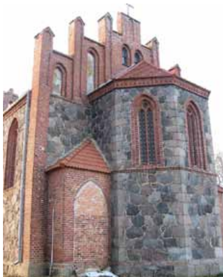
Wygląd starannie wykonanych, kamiennie- -ceglanych ścian wschodniej części kościoła.
