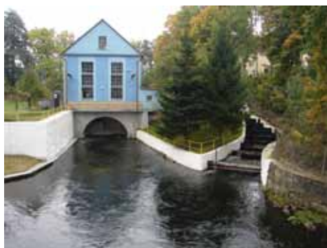
Trzebiatów, ul. Mostowa - zespół elektrowni wodnej, fot. W. Witek 2010
