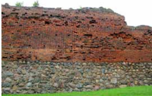
2012 rok. Struktura niszczonego muru południowego.
