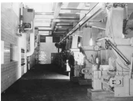
Maszynownia urządzeń grzewczych
