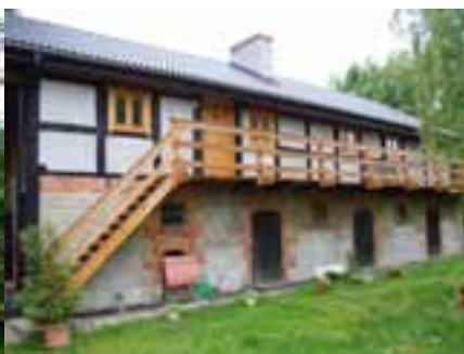
Budynek inwentarsko-bramny w Słownie po pracach remontowych, fot. W. Witek, 2012
