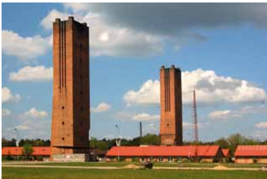
Wieże dawnego Ordensburga nad Krosinem, widok od strony południowej. Fot. M. Leszczelowski
