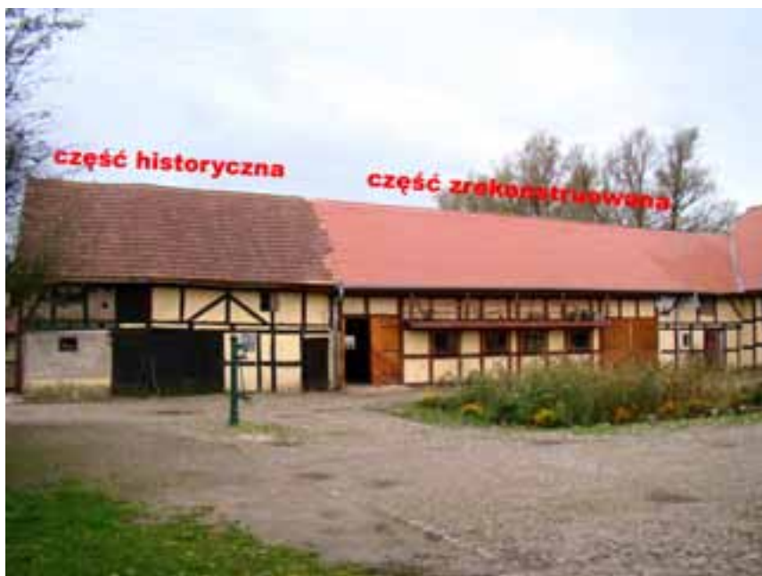
Budynek inwentarski w Gosławiu - stan po rewaloryzacji, fot. W. Witek, 2012
