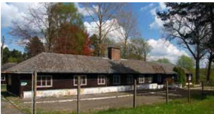
Barak z kotłownią w 2007 r.
