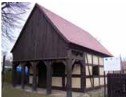
Kuźnia w Dolsku - po rewaloryzacji i rekonstrukcji, fot. W. Witek, 2014
