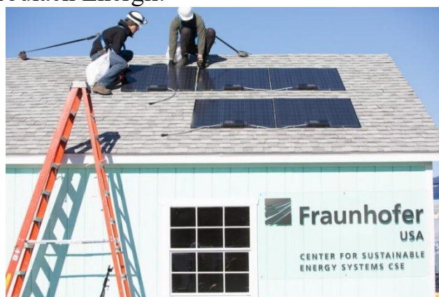
Firma Fraunhofer CSE zademonstrowała Plug and Play fotowoltaiczny system zainstalowany i uruchomiony od zera w ciągu 75 minut . Photo: Fraunhofer CSE
