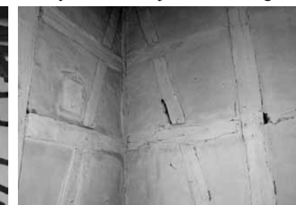
Uwidoczniona we wnętrzu konstrukcja szkieletowa, scalona kolorystycznie z wypełnieniem i bielona; Siecino gm. Ostrowice, kościół; fot. Aleksandra Hamberg-Federowicz 2-13 (przed remontem)
