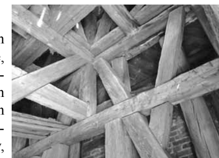
Wnętrze wieży ze szkieletową drewnianą konstrukcją trzonu i zawieszenia dzwonów; Mielenko Drawski gm. Drawsko Pom.; kościół; fot. Aleksandra Hamberg-Federowicz 2013
