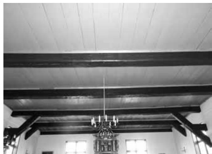
Płaski belkowy strop nagi z zastrzałami przyściennymi, malowany olejno – ściany otynkowane na gładko; Osiek Drawski gm. Wierzchowo, kościół; fot. Aleksandra Hamberg-Federowicz 2013
