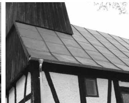
Tymczasowe pokrycie nawy wykonane z blachy układanej na rąb; Stare Worowo, gm. Złocieniec, kościół; fot. Aleksandra Hamberg-Federowicz 2013
