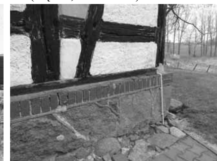
Kamienny cokół ryglowych ścian obwodowych; Stare Worowo, gm. Złocieniec, kościół; fot. Aleksandra Hamberg-Federowicz 2013
