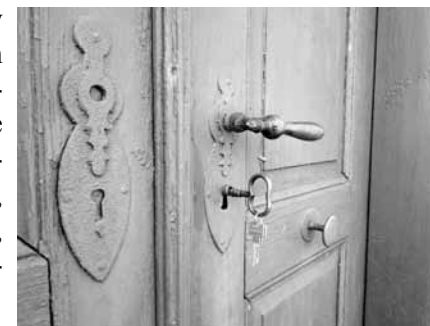
Oryginalne okucia drzwi głównych, z zamkiem, klamką sztyldami; Gronowo gm. Ostrowice, kościół; fot. Aleksandra Hamberg-Federowicz 2013
