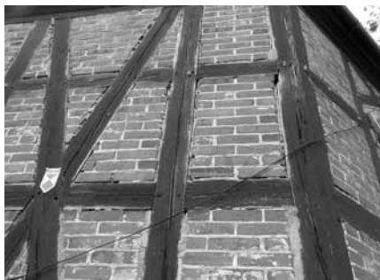
Ściany ryglowe z uwidocznieniem w elewacji drewnianej konstrukcji i wypełnieniem fachów cegłą ceramiczną licową; Nętno gm. Drawsko Pom., kościół; fot. Aleksandra Hamberg-Federowicz 2013
