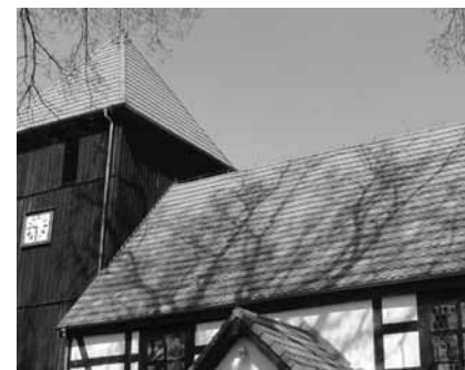
Nowe pokrycia dachowe nawy i wieży z dachówki ceramicznej karpiówki w koronkę, ściany z uwidocznioną strukturą, wieża oszalowana deskami; Osiek Drawski gm. Wierzchowo, kościół; fot. Aleksandra Hamberg-Federowicz 2013
