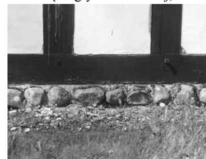
Kamienny cokół ryglowych ścian obwodowych; Osiek Drawski, gm. Wierzchowo, kościół; fot. Aleksandra Hamberg-Federowicz 2013
