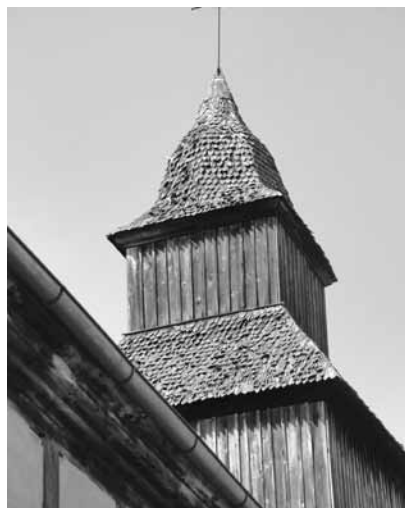
Hełm wieży pokryty drewnianym, drobnym gontem, ściany wieży oszalowane deskami; Gronowo gm. Ostrowice, kościół; fot. Aleksandra Hamberg-Federowicz 2-13 (przed remontem)
