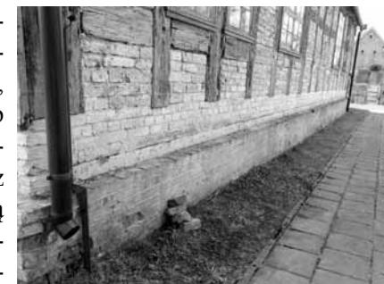
Cokół murowany z cegły ceramicznej, podwyższony w czasie remontu – przy skróceniu dolnej partii ściany ryglowej i usunięciu podwaliny; Mielenko Drawskie, gm. Drawsko Pom., kościół; fot. Aleksandra Hamberg-Federowicz 2013
