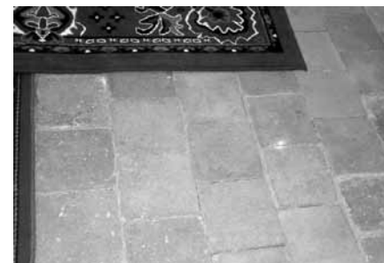
Posadzka z oryginalnych kwadratowych kształtek ceramicznych; Giżyno gm. Kalisz Pom., kościół; fot. Aleksandra Hamberg-Federowicz 2013
