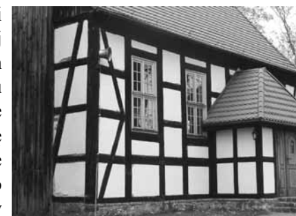
Ściany ryglowe z uwidocznieniem w elewacji drewnianej konstrukcji, skonstrastowanej kolorystycznie z tynkowanym wypełnieniem fachów; Cieszyno gm. Złocieniec, kościół; fot. Aleksandra Hamberg-Federowicz 2013
