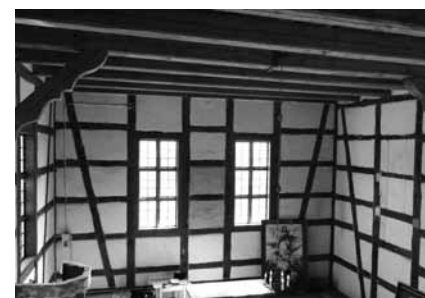
Uwidoczniona we wnętrzu konstrukcja szkieletowa, skonstrastowana barwnie; Gronowo gm. Ostrowice, kościół; fot. Aleksandra Hamberg-Federowicz 2013 (przed remontem)
