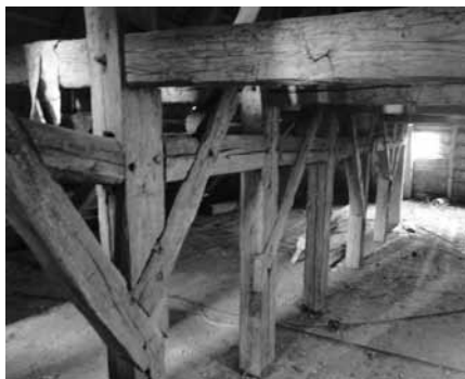
Ręcznie obrabiana i wiązana więźba dachowa nawy; Dołgie gm. Ostrowice, kościół; fot. Aleksandra Hamberg-Federowicz 2013
