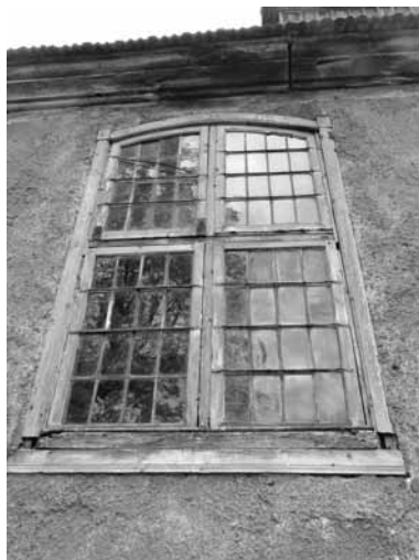
Oryginalne okno ze szkleniem szkłem formowanym ręcznie; Dołgie gm. Ostrowice, kościół; fot. Aleksandra Hamberg-Federowicz 2013
