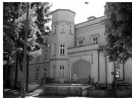
Ryc. 4. Pałac w Karwicach
