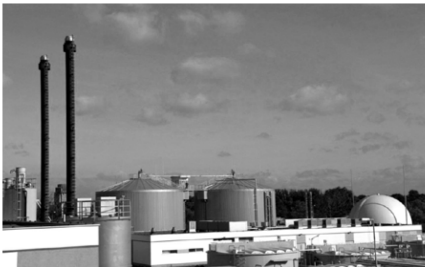
Energetyczne wykorzystanie ścieków w oczyszczalni ścieków „Pomorzany” w Szczecinie”
