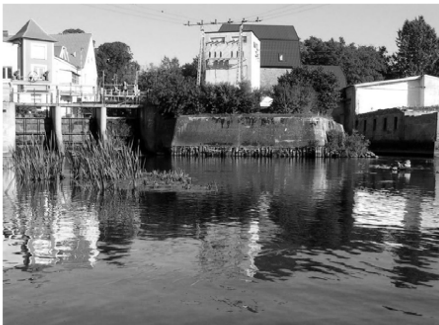
Elektrownia wodna w Resku.
