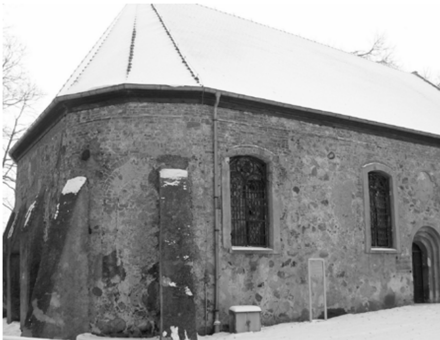
Struktura murów kościoła pw. Św Trójcy (fot. Zb. Januszaniec, 2013 r.)
