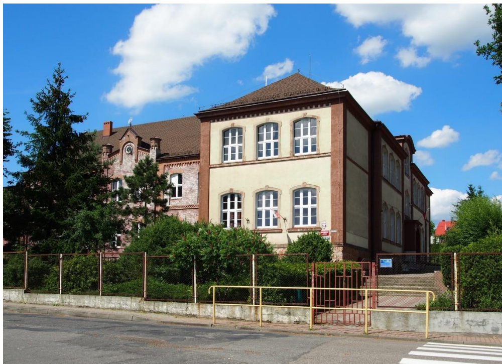
Rys. 84. Szkoła, ul. Słoneczna 27, fot. R. Walkiewicz
