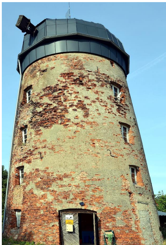
Rys. 125. Obecny stan wiatraka w Zagoździe, 2020r, fot.ZM
