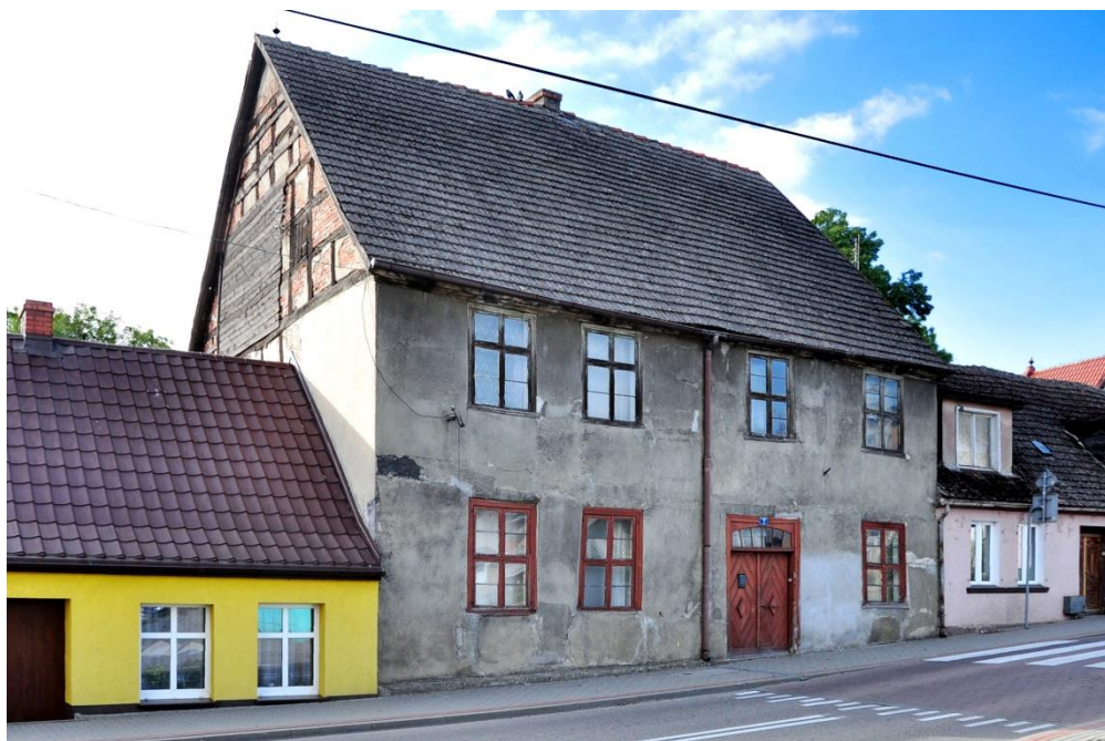
Rys. 82. Dawna komora celna, ul. Drahimska 7, fot. R. Walkiewicz
