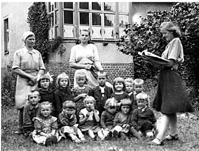
Rys. 27. Dzieci przedszkolne przed budynkiem Plebani w Siemczynie.
