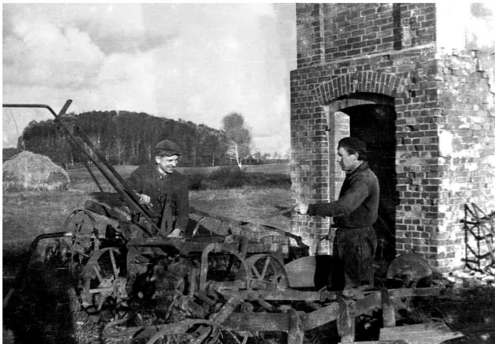
Rys. 3. Pracownicy resztówki sprawdzają stan techniczny maszyn - 1948 rok.
