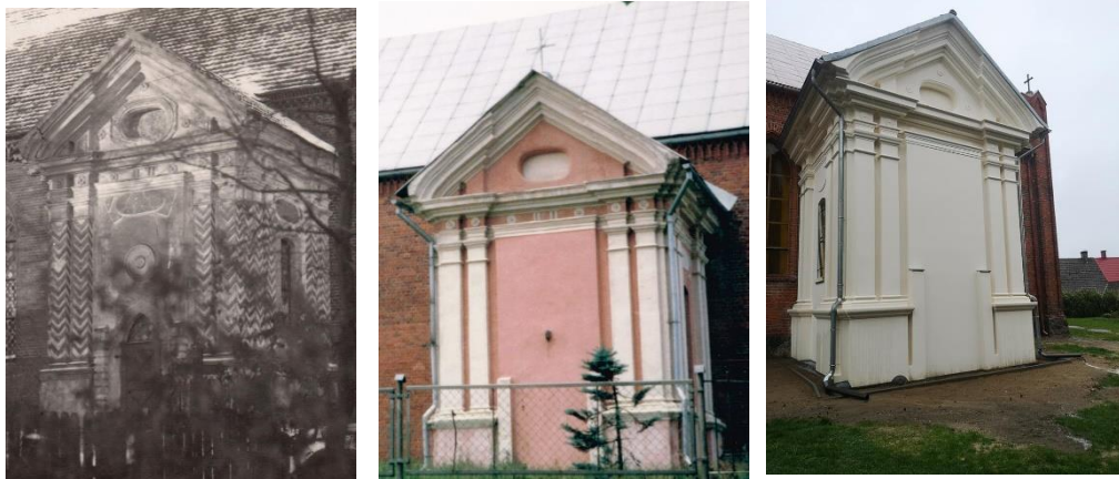
Rys. 8. Od lewej: Kaplica - dawny wygląd, Kaplica - 1985 r., Kaplica - obecnie po remoncie.
