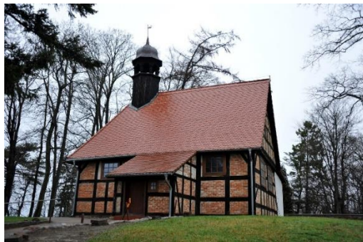
Rys. 2. Kościół w Objeździe po remoncie Fot: diecezjapelpin.pl
