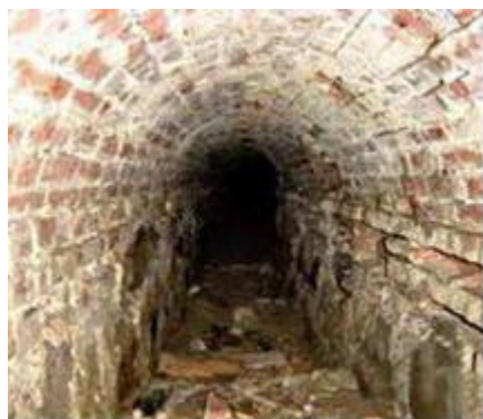
Rys. 3. Podziemny tunel - kanał w parku
