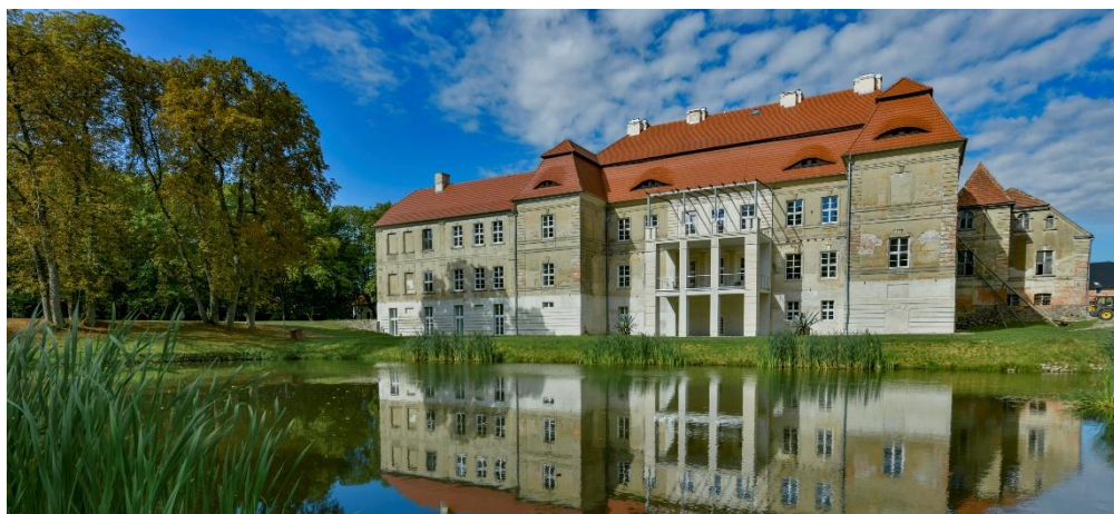
Fot. 13. Pałac w Siemczynie fasada ogrodowa stan z 2022 roku.
