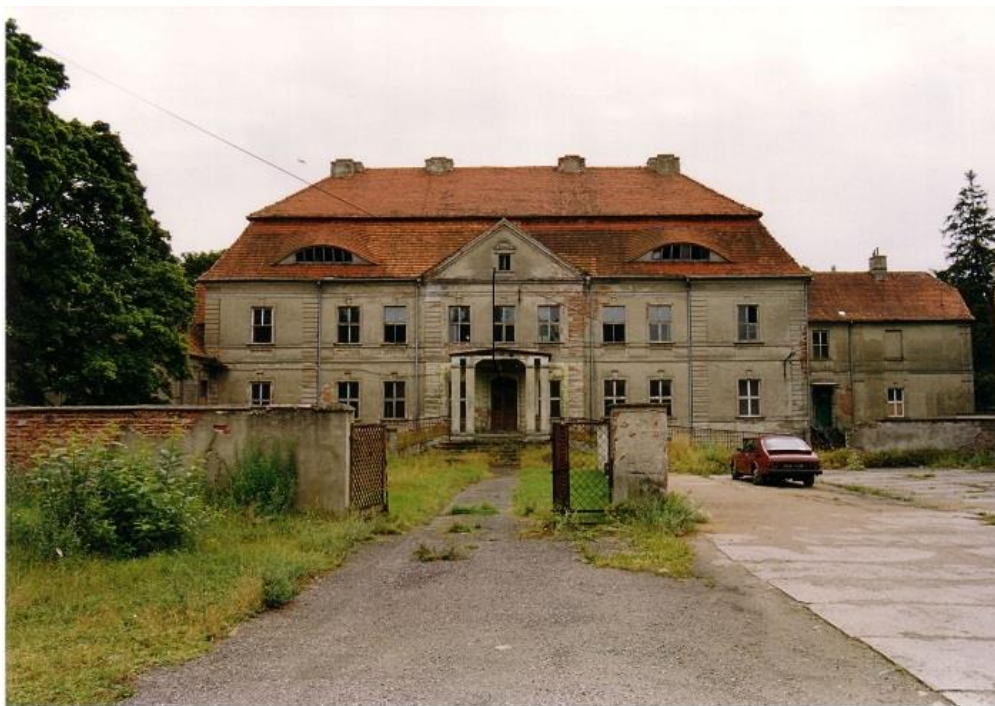
Rys. 1. Stan pałacu przed zakupem.
