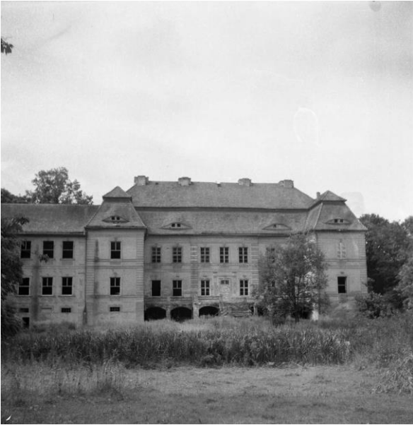
Rys. 5. Rok 1951 - Nadal brakuje szyb w oknach.
