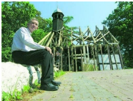
Rys. 1 .Ks. Stanisław Fortuński na tle kościoła w Objeździe w trakcie remontu 2006 rok. Fot: slupsk.nasze.miasto.pl.
