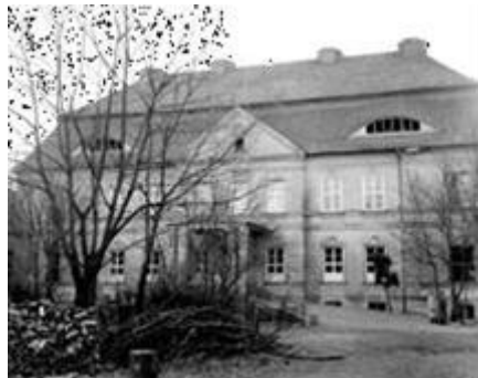
Rys. 7. Widok na elewację frontową. Lata 60-te XX wieku. Foto: archiwum koszalińskiej Delegatury Wojewódzkiego Urzędu Ochrony Zabytków w Szczecinie.
