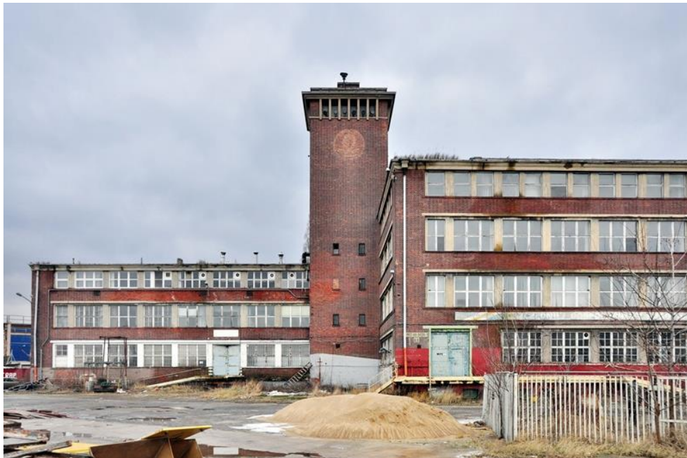
6. Widok elewacji i wieży od strony wschodniej, fot. archiwum BMKZ UM Szczecin.
