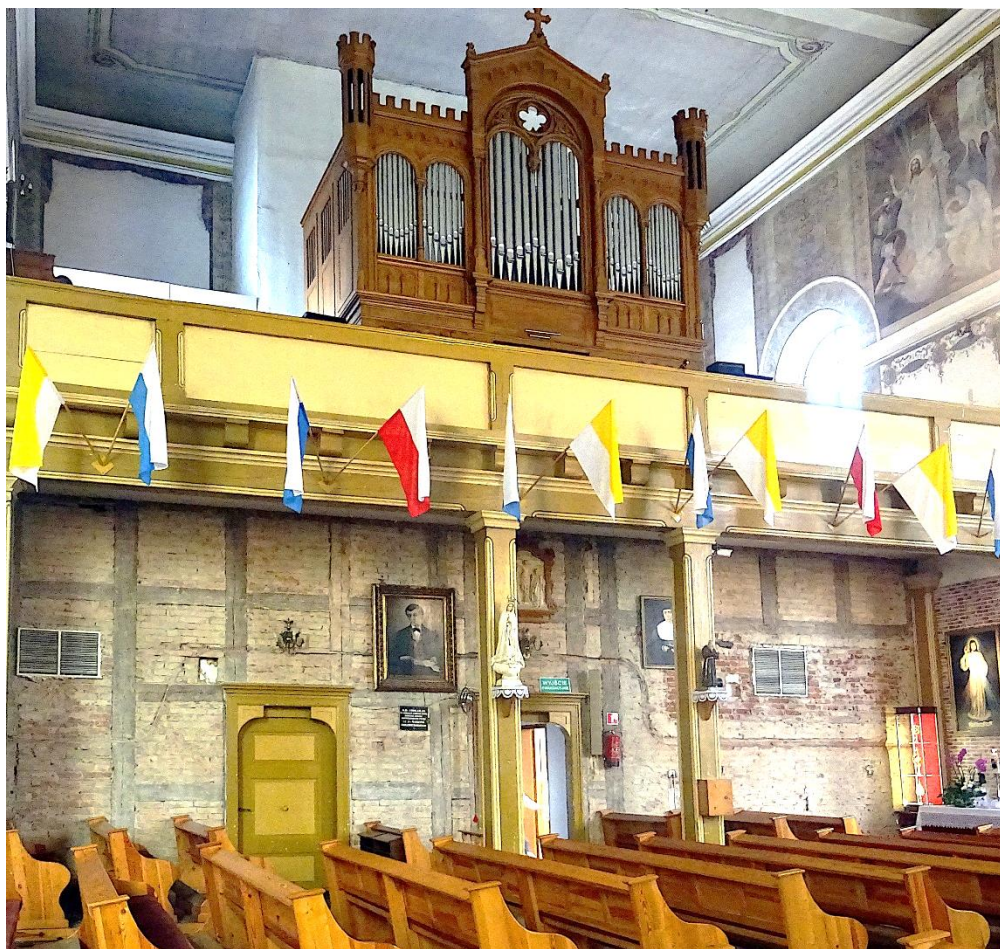
46. Pozbawiona tynku ściana pod emporą organową (fot. Zb. Januszaniec, 2021 r.).
